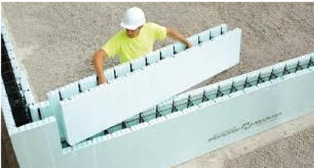
O sistema ICF acaba por criar uma estrutura notavelmente sólida e durável que pode ser recoberta por uma variedade de acabamentos (como o estuque, por exemplo). Usados como cofragem definitiva, os blocos de EPS proporcionam um excecional isolamento térmico e acústico aos edifícios finalizados. Os principais argumentos da construção ICF (Insulated Concrete Forms) residem, assim, na sua elevada eficiência, robustez e durabilidade.
